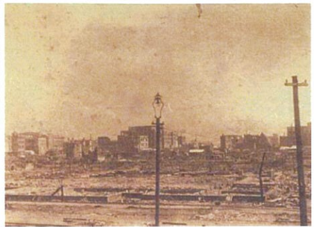
東京駅前の焼け跡、日本橋方面 © 国土交通省気象庁関東大震災写真集
